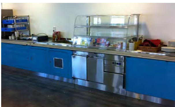
Serveringsdisk RBP med snudd monter
