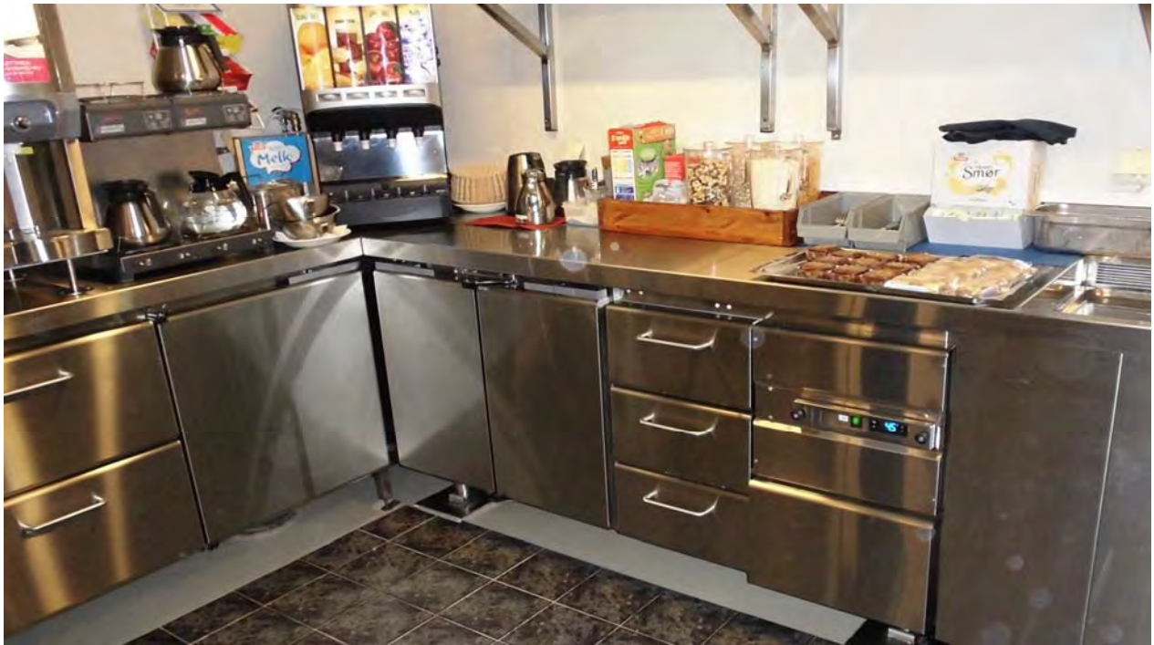
Kjølt arbeidsbord RBE og rustfrie benker
