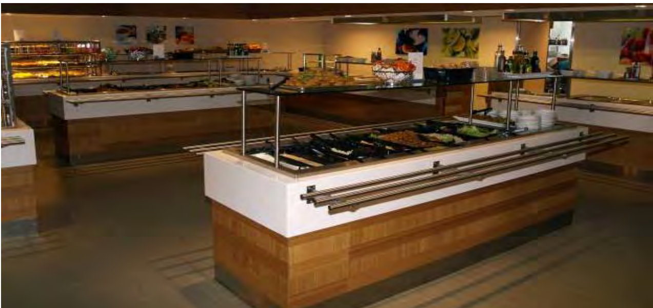
Drop in kjølebrønner KBK, overhulle OHG og rustfri rør brettbane
